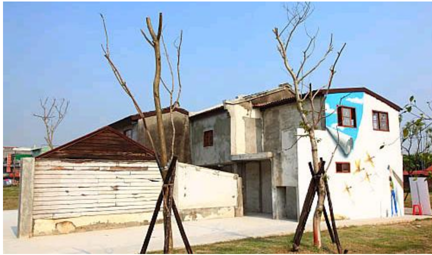
照片 3-2-1: 板橋浮洲親民公園-藝術眷築
