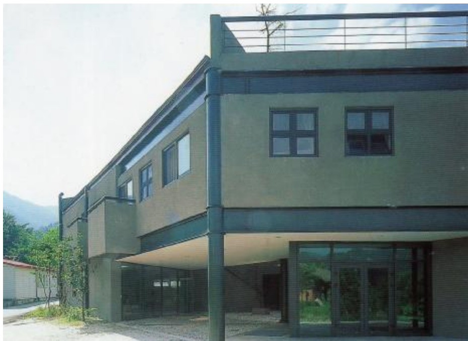
圖 2-3-10 東側(主出入口)
